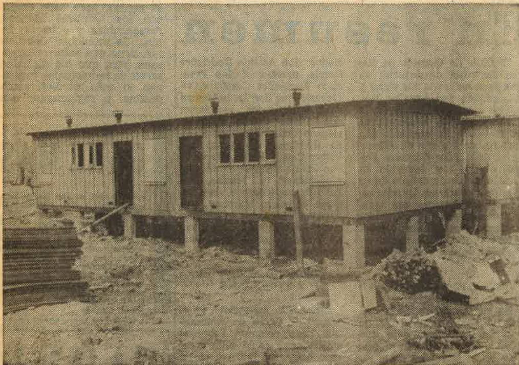
Una vivienda completamente terminada. Ahora falta la pintura y las acometidas pertinentes
